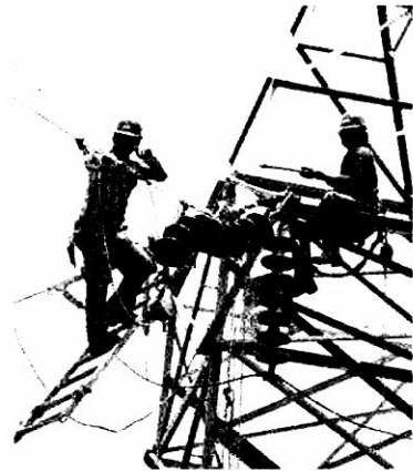
Personal de Chilectra reparando una torre de electricidad, que el marxismo, "enemigo de la luz", había "pacíficamente" derribado.
